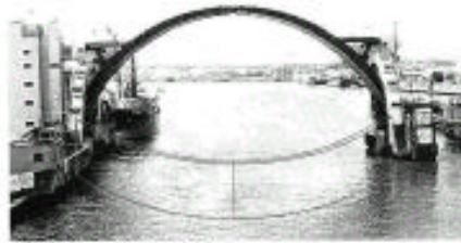
安治川水門 (建設中) (建設中) (建設中)
