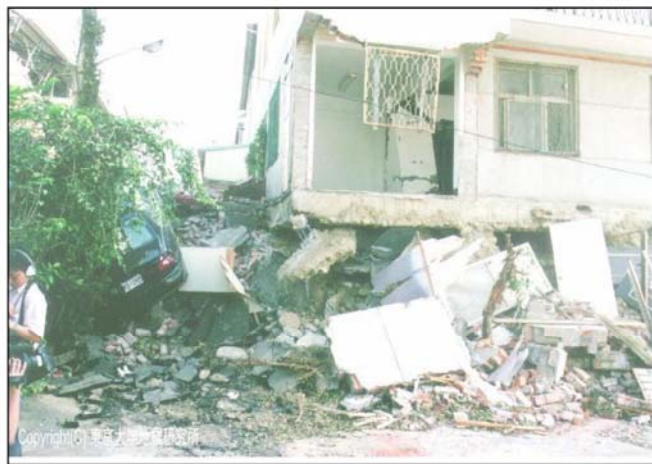
台中市大坑(東側が3m隆起, 水平方向に4m左にずれている。)
