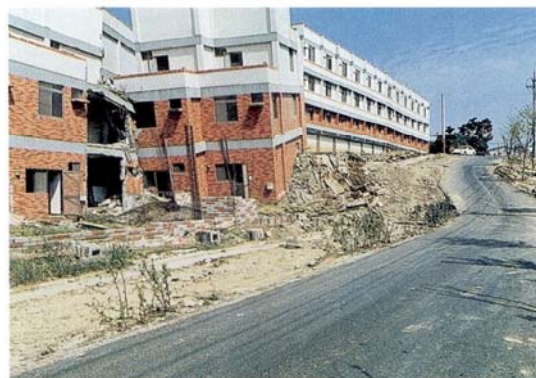
写真-12 豊原市の地震断層直上の倒壊ビル
