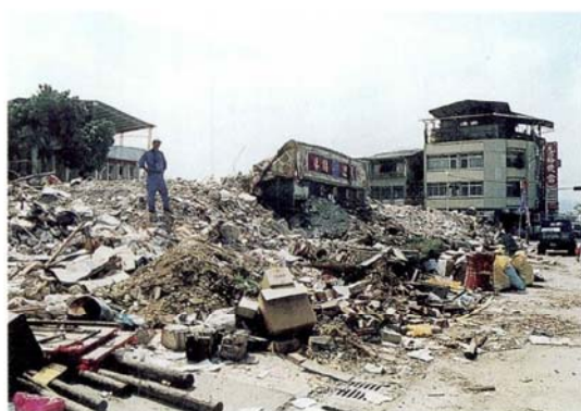
写真-3 完全に潰れた埔里鎮公(市役所)
