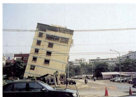
写真-6 段丘上の町、東勢の倒壊ビル
