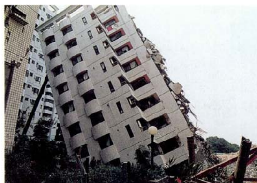
写真-5 大里市の倒壊ビル 沼の埋めたて地に建設
