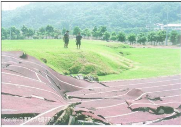
台中県霧峰(東側が2m隆起している。)
