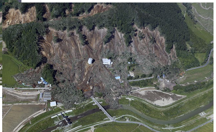
厚真町豊里浄水場 被災現場
