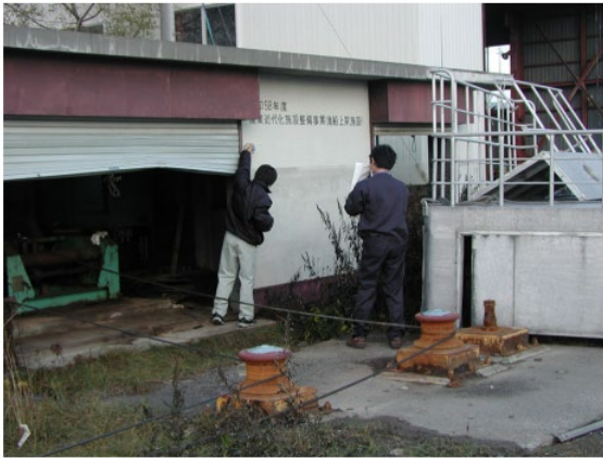
図-3 大津漁港の津波痕跡の例
