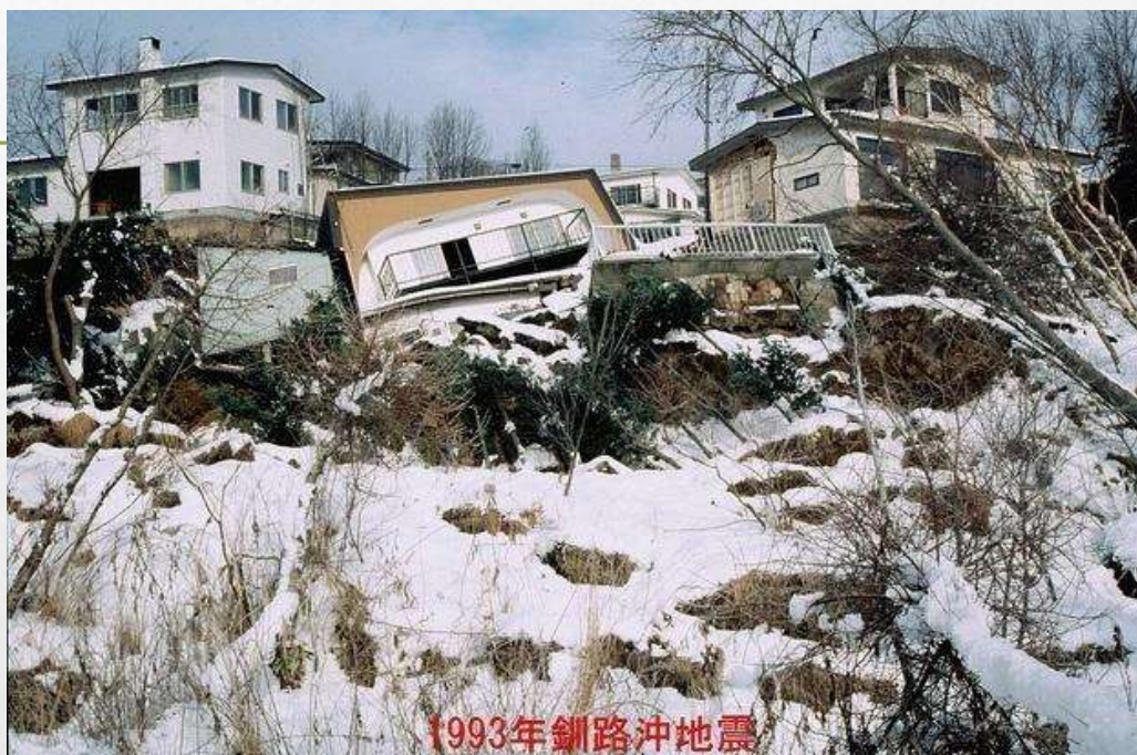
平成5年釧路沖地震（緑が岡5丁目地区の宅地崩壊の状況）
