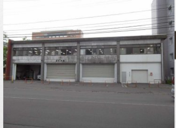
第2庁舎の状況（解体前）
