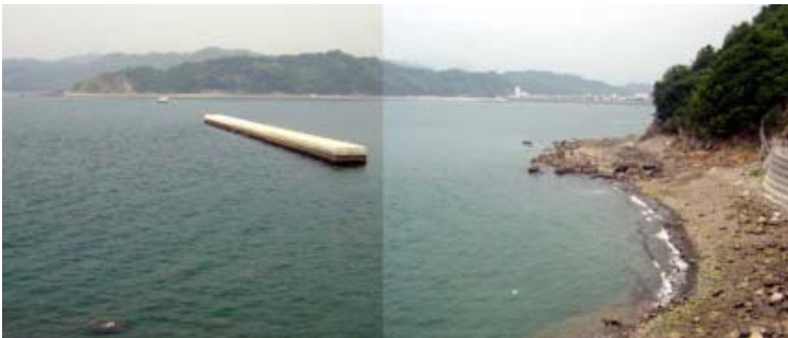
写真 : 湯浅広港津波防波堤の整備状況(2005年7月24日現在)
