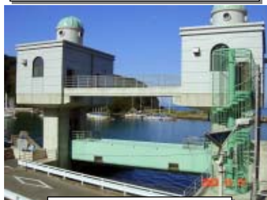
浜川河口の津波水門
