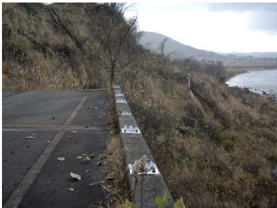
地震によって落盤・崩落した県道
