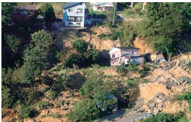
地滑りによって倒壊した家屋たち(旧山古志村)
