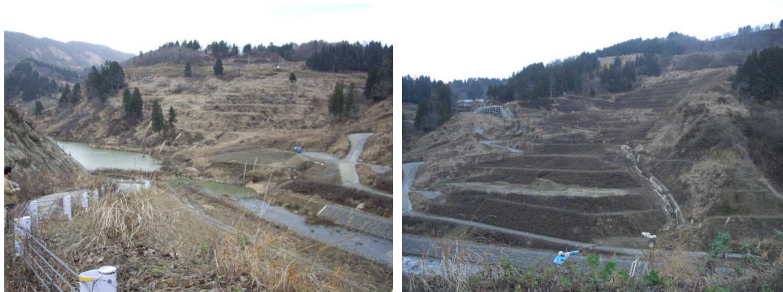
国の直轄事業により復旧が進む寺野地区
