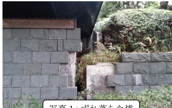
写真1: ずれ落ちた橋
