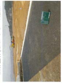
残存型枠使用によるコスト削減
