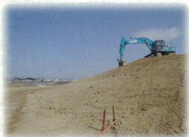
第1号丘(モデル丘)造成工事 造成土の約6割に再生ガレキを使用
