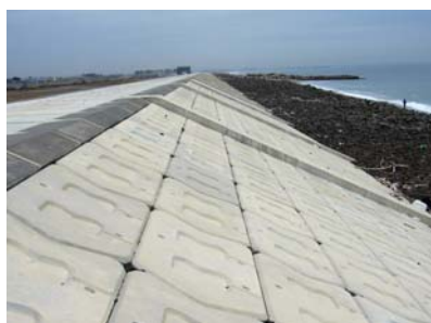
（天端高 T.P.+7.2m(復旧延長 29km)の海岸堤防）
