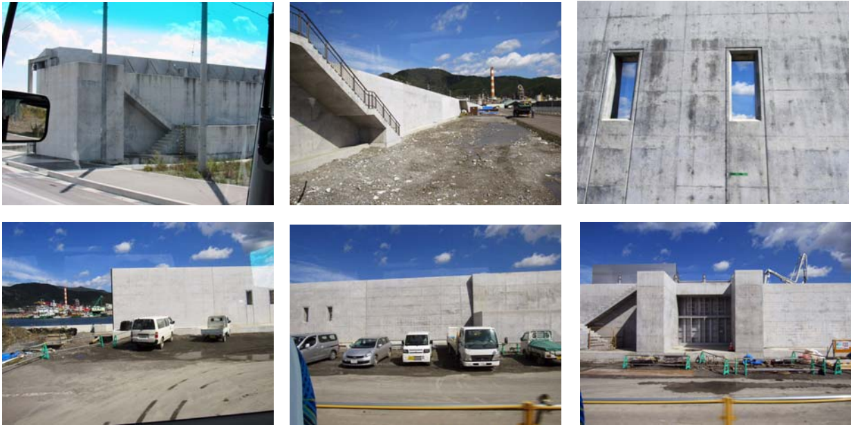
(防潮堤の整備状況(天端高(旧:T.P.+3.0~3.5m → 新:T.P.+m7.5m))
