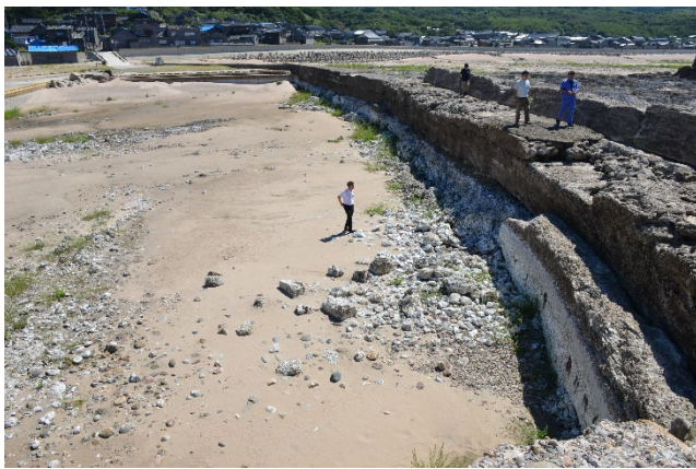
2024/9/10 撮影：黒島漁港（3.2m 隆起：強震動により崩壊している防波堤天端）
