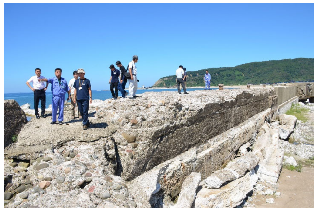
2024/9/10 撮影：黒島漁港（3.2m 隆起：強震動により崩壊している防波堤天端）
