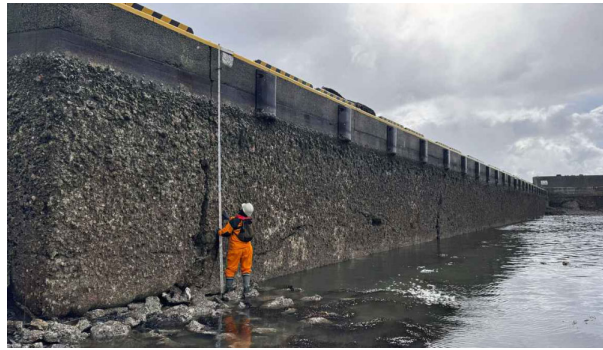
※引用：産経新聞 HP (3.6m 隆起した物揚岸壁)
